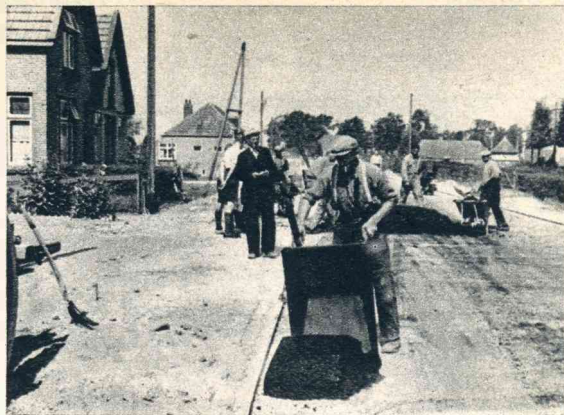
De werkzaamheden aan den weg Kampen-Zwolle vorderen: men is reeds toe aan het asfalteren van het wegdek.
