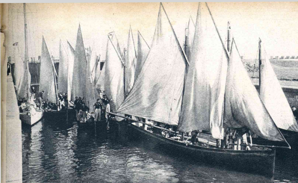
De vloot in de sluis te Den Oever.
