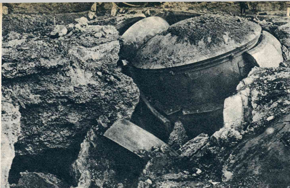
De zwaar door beton en pantser versterkte Belgische forten konden slechts door zwaar geschut worden overweldigd. Maar de uitwerking van de Duitse 12 cm. kanonnen was dan ook vernietigend. Een enkel schot uit zulk een mortier was in staat om het dikste betondek en het sterkste pantser in puin te schieten en te doorboren. Het resultaat van één treffer op een pantserfort van het fort Loncin.
