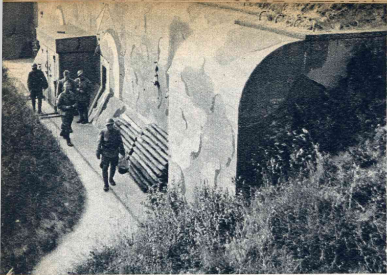
Massa's beton zijn gebruikt voor de kazematten voor infanterie en artillerie.
