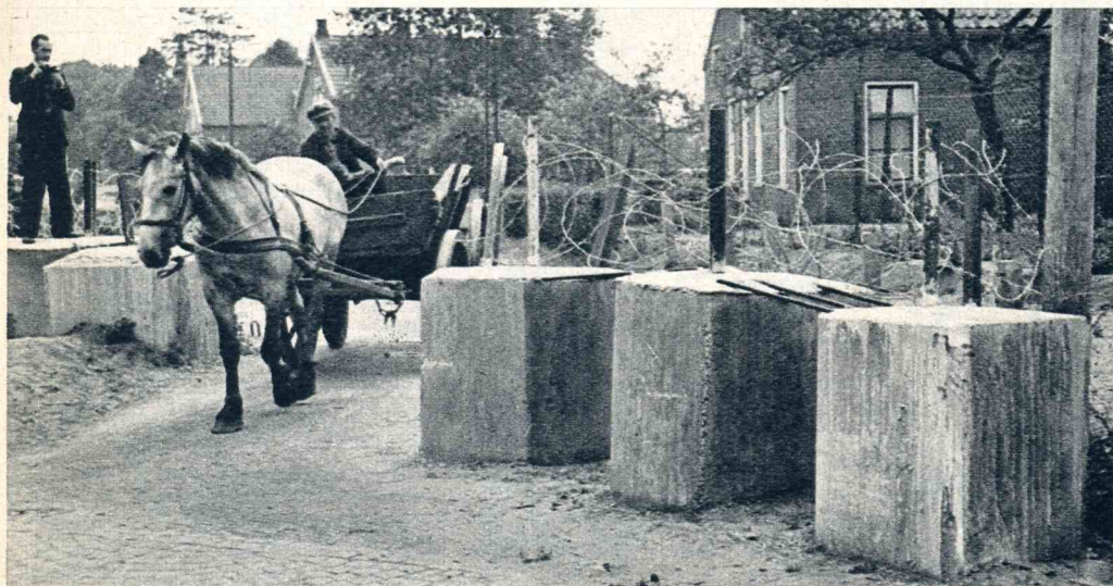
In de hindernis tegen pantserwagens, gemaakt van putringen en prikkeldraad, is voor het verkeer een smalle opening gelaten. Indien noodig kan deze opening natuurlijk onmiddellijk gesloten worden.
