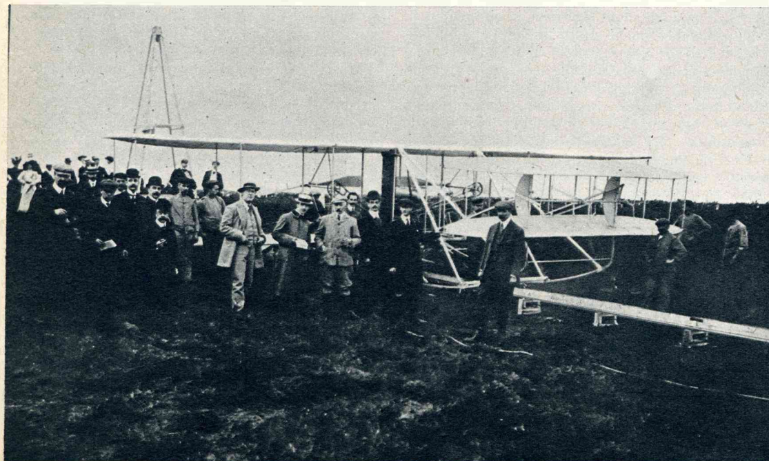
De Wright-tweedekker op de rail. Op den achtergrond de 8 m. hooge stellage, waaraan een 700 kg. zwaar valgewicht hing, dat het vliegtuig deed starten.
