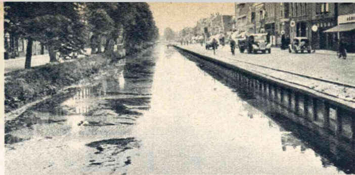
De gemeenteraad van Hoogeveen heeft besloten het kanaal van het Kruis tot de Brink en langs de Willemsskade tot het Omkanaal in eigendom over te nemen van de Kanaal Mij. Er kan nu verder worden gewerkt aan het dempingsplan, terwijl verbeteringen (verbreding, beschoeiing, enz.) kunnen worden uitgevoerd. Het verkeer op deze kade, waarvan men hier een foto ziet, zal er tevens mede gebaat zijn.
