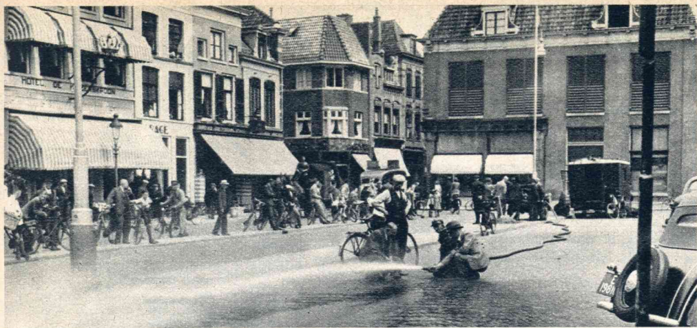
Voor den Luchtbeschermingsdienst zijn te Deventer op vier plaatsen brandputten geboord: dezer dagen nam de brandweer er proeven met de hoeveelheid water, waterdruk, enz.
