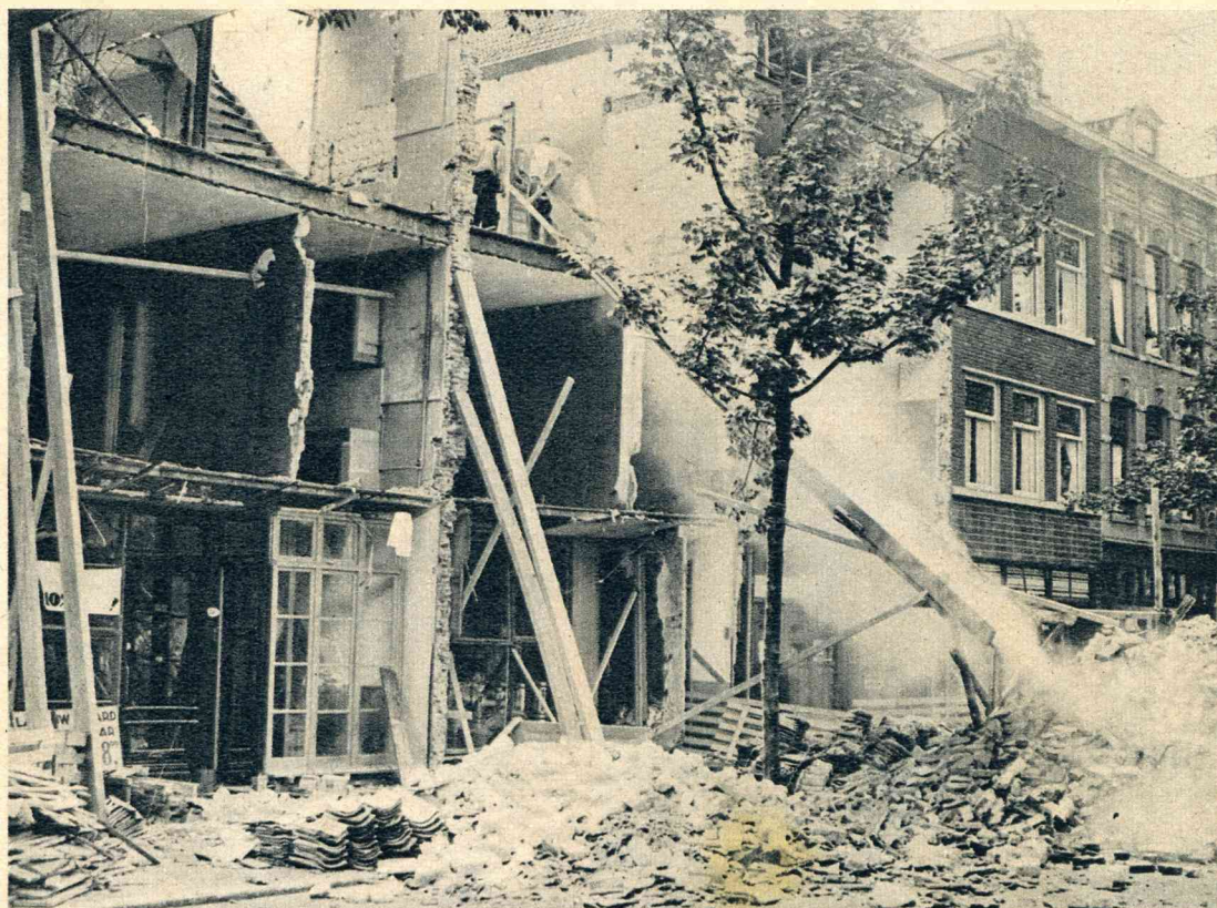
Een drietal panden in de Zwart Jansstraat te Rotterdam waarvan de gevels vernieuwd werden, bleken in een staat van verzakking te verkeerren, zoodat de bewoners, die nog in het achtergedeelte verblijf hielden, in allerijl moesten vluchten. Aangezien deze huizen een gevaar voor de omgeving opleverden, werd reeds spoedig met de afbraak begonnen.
