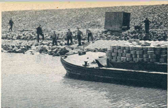
Het leggen van bazaltblokken aan den afsluitdijk nabij Urk. De zeskantige steenen vormen een regelmatig profiel.
