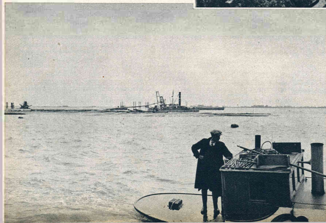
De dijkbouw langs het Kampereiland. De uitstekende palen in het midden geven aan waar de grond moet worden gestort. Op den voorgrond het motorbootje van den inspectiedienst.
