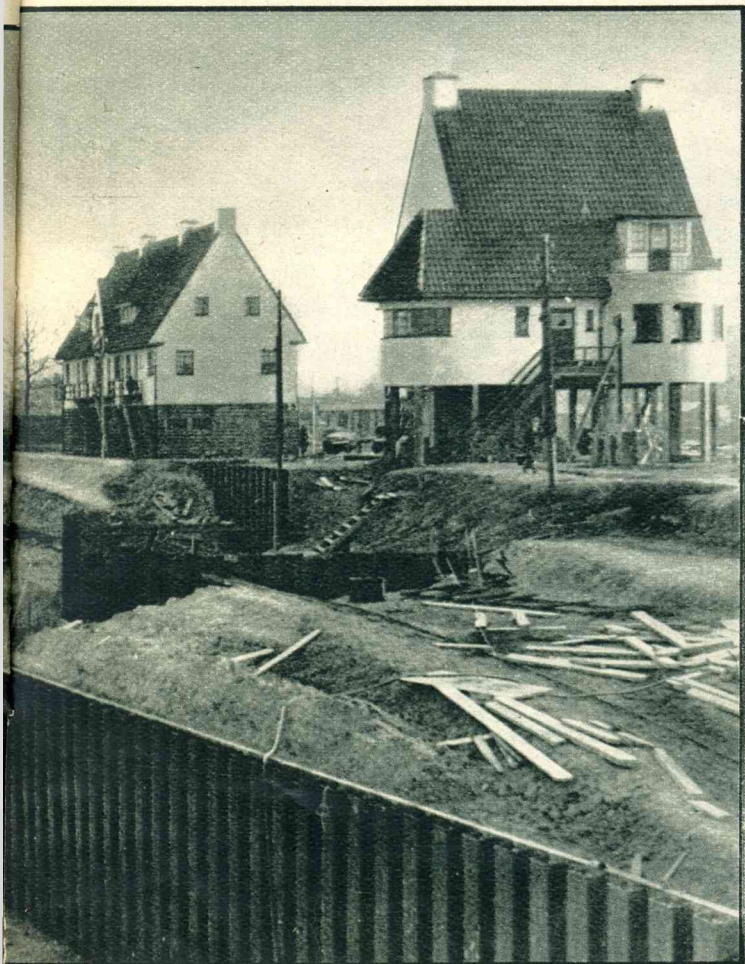
Als gevolg van het hoogteverschil van het terrein langs het kanaal is voor den bouw van de sluis bij Delden geen diep graafwerk noodig. Omdat het terrein later opgespoten wordt, heeft men de sluiswachtershuizen op palen gebouwd; later zal de ruimte onder den vloer worden gevuld.
