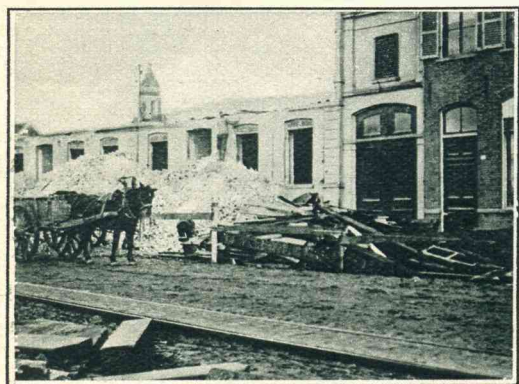
Op de Rijnkade te Arnhem wordt ruimte gemaakt voor de opritten der nieuwe Rijnbrug.
