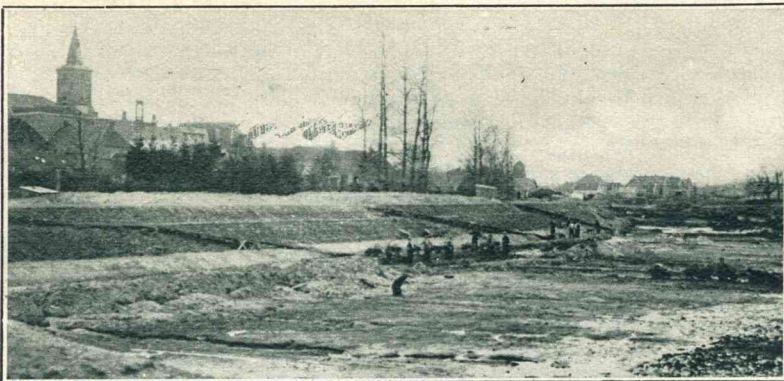
Hardenberg (O.) krijgt een ruime haven aan de Vecht, ter vervanging van den ouden, doodlopenden Vecht-arm, welke onvoldoende was. Het werk wordt in werkverschaffing door een honderd arbeiders, zonder machines, uitgevoerd en begint het einde te naderen.
