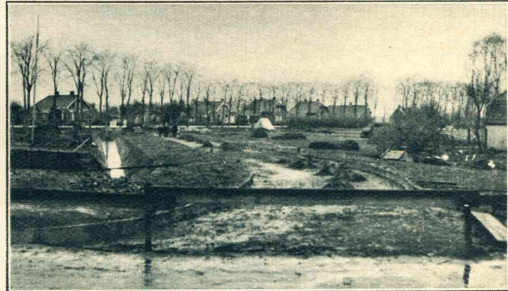
Ook te Oostwolde worden de scherpe bochten in den drukken weg naar de Leek en Westerkwartier (Gr.) gelijk gemaakt en door nieuwe rechte stukken vervangen, om het verkeer veiliger te maken.
