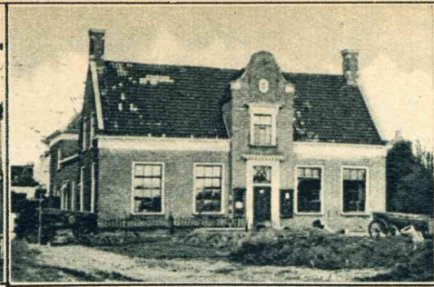
Het gemeentehuis van Bergum (Fr.) staat het veer keer in den weg; het zal dus worden afgebroken.
