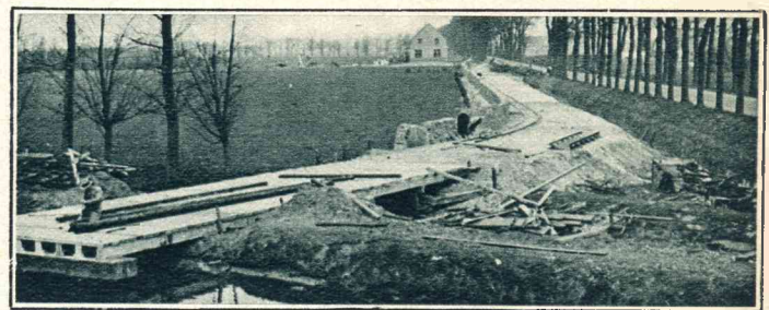
Tijdens den bouw van een betonnen brug, die de oude Ganzenbrug te Heins in den weg Almelo — Zwolle zal vervangen, zal het verkeer geleid worden over een hulpweg en een noodbrug.
