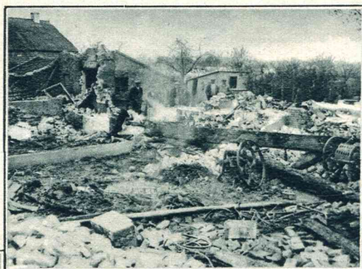
Het boerenbedrijf van den heer N. Peters op de Plak te Bemmel (Betuwe) brandde tot den grond toe af. De brandweer kon weinig tegen het vuur uitrichten, daar er gebrek aan water was.
