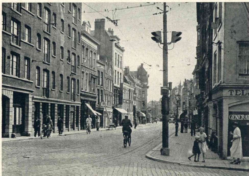
Een kijkje op den Schiedamschen dijk.
