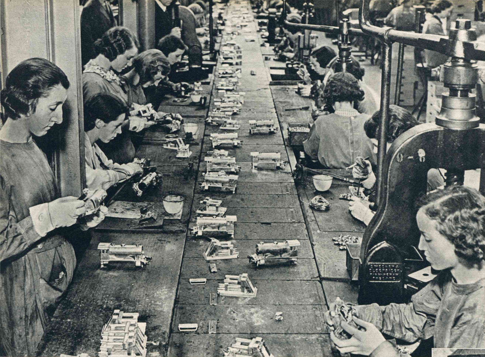
Telkens een volgende handgreep, een nieuw onderdeel — zoo worden aan den loopenden band de treinstellen incengezet. Maar bij zoo'n zwaarder treinstel zijn er dan ook — afgezien van de fabricage der onderdeelen — 2732 afzonderlijke verrichtingen noodig om het te monteeren.
