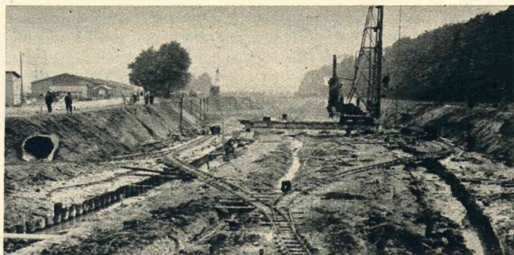
De tunnel vordert reeds! — De opgravingen aan den Rechter-Maasoever te Rotterdam zijn in rollen gang. Aan weerszijden wordt een stalen damafzetting in den grond geheid, waartusschen de toegangsrit tot den tunnel wordt aangelegd.
