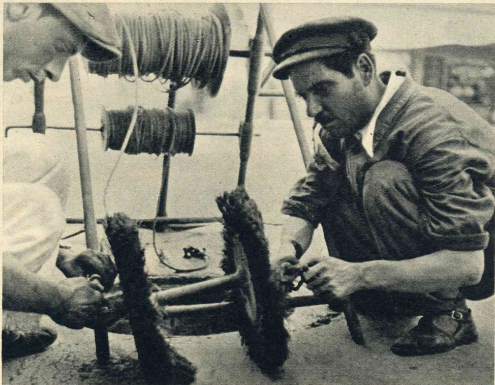
Deze ronde, dubbele bezems passen precies in de smalle buizen en worden vastgemaakt aan den halster van den hond. Het dier trekt dien bezem door de buis heen en reinigt ze aldus van alles wat aan de wanden mocht blijven vastzitten.
