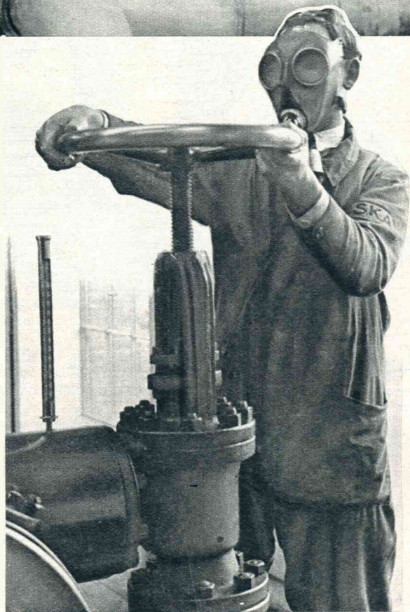
Waar koude gedistribueerd wordt. — Een complex afsluiters, door middel waarvan het mogelijk is de richting, waarin de pekels naar de betonplaat onder de ijsbaan stroomt, om te keeren. Op deze wijze is het mogelijk, steeds dien kant van de baan, die het het meest noodig heeft, de meeste koude toe te voeren.
