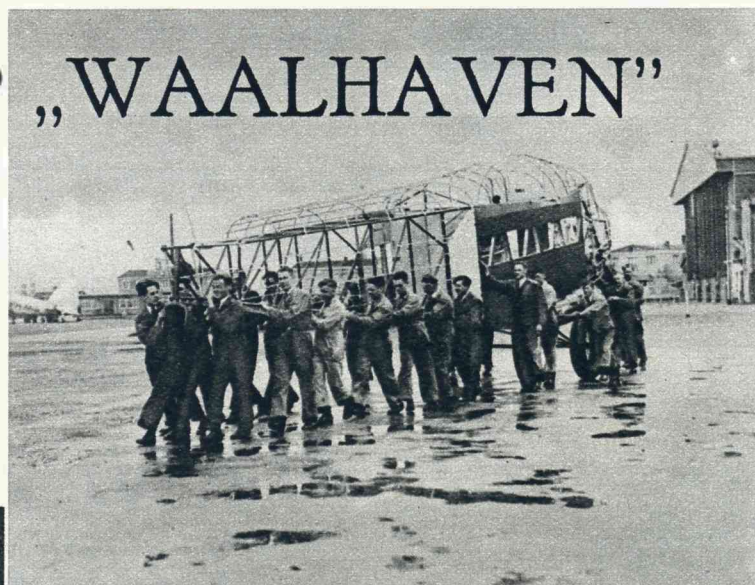
De werkzaamheden gaan voort.
