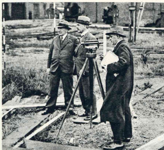
Zoals men weet wordt het schip gebouwd door de Droogdok Mij., Wilton, Piet Smit en „Vlissingen”. Hier zien we de opmetingen op het terrein der Droogdok Mij.
