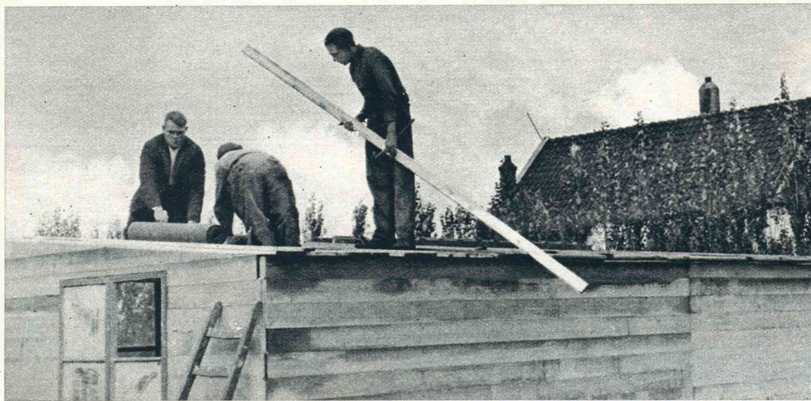
Er wordt aan gewerkt!
