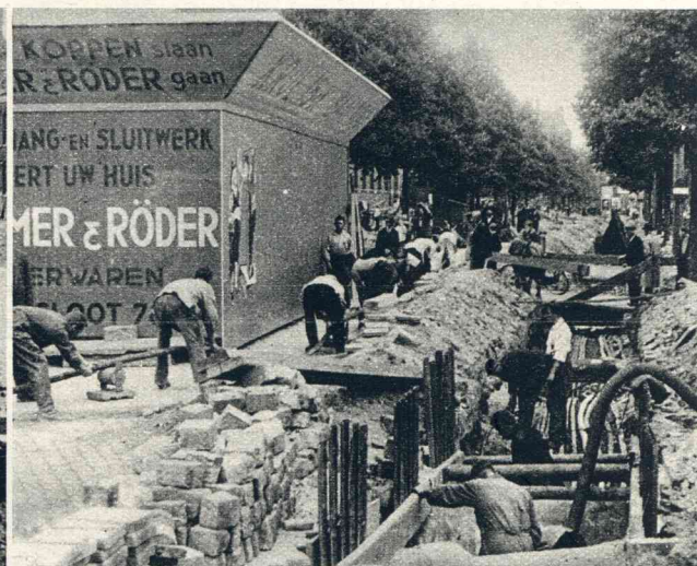
Kabels en buizen moeten verhuizen.
