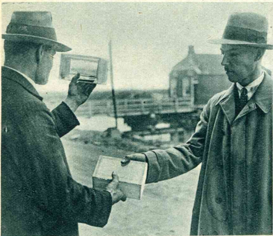
Het nieuwste! Bij den bouw van een Tricot-fabriek te Wildervank gebruikt men glazen steenen. Hier zien we het nieuwste product.
