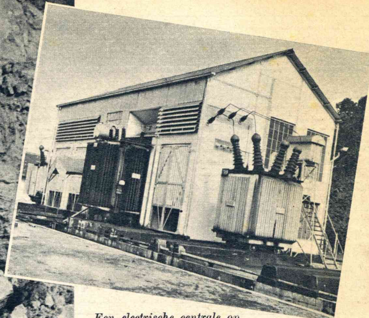
Een elektrische centrale op de terreinen van de tinwinningmaatschappij.
