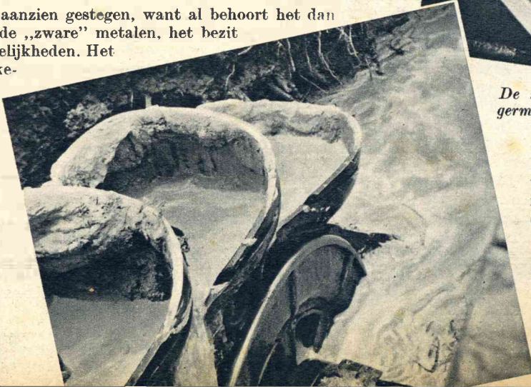
De losgespoten grond wordt door de emmers van den baggermolen opgehaald.
