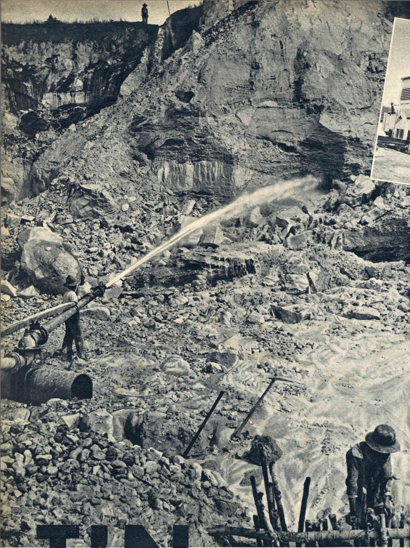
Een waterkanon, dat den grond losspuut en vermoddert.
