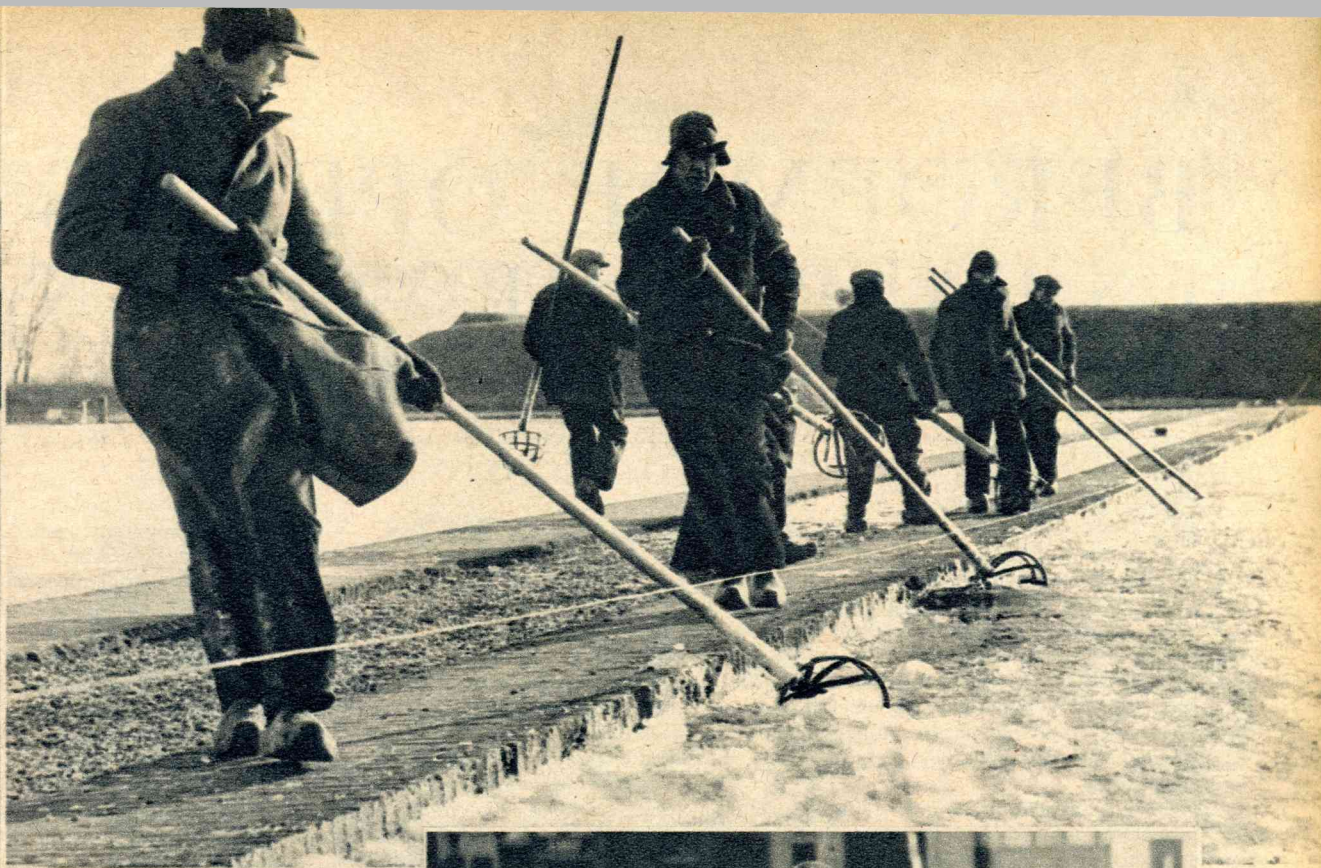
In de ijzige koude werken de arbeiders van het Amsterdamsche waterleidingbedrijf te Weesperkarspel aan de filters om de randen ijsvrij te houden, daar deze anders stuk zouden vriezen. Het met de lange houten hamers stukgeslagen ijs wordt met stalen schepnetten naar de pompen gevoerd.
