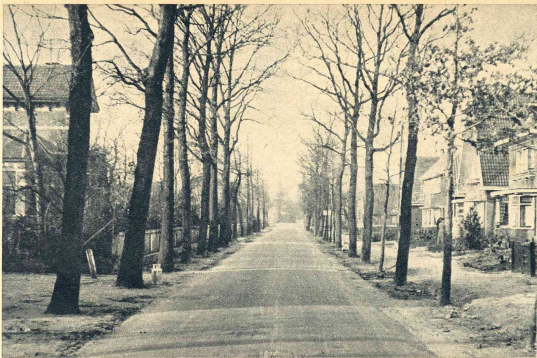
Alle eikenboomen aan den Eibergschenweg te Neede zullen geveld worden, zoodat het aanbrengen van trottoirs langs dien weg voortgang kan vinden. Rechts op de foto de aarden baan voor het trottoir, dat reeds gedeeltelijk gereed is.
