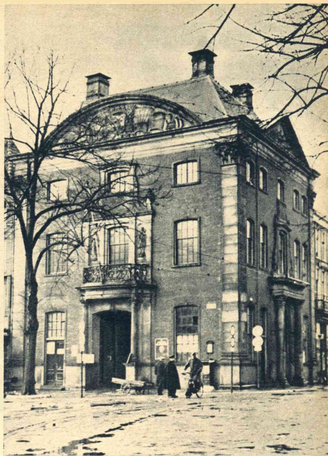
Het uit 1761 dateerende Waaggebouw op de Markt te Arnhem, dat nog steeds een sieraad voor het groote plein is, huisvest thans het bureau van de Vrouwelijke Vrijwillige Hulp, terwijl er tevens een opslagplaats voor de ingeleverde gedragen kleding gevestigd is.
