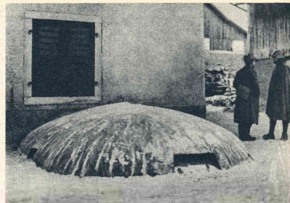
Betonnen kazemat, die een belangrijken toegangsweg bestrijkt. Deze versterking wordt naar de wisseling van het seizoen wit of groen beschilderd.
