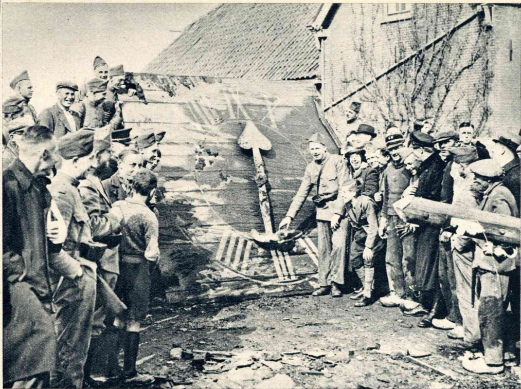
De wijzerplaat is er nog vrij goed afgekomen, doch het was een „looze” plaat, want er zat geen uurwerk achter, omdat dit in den scheeven toren toch niet goed liep.
