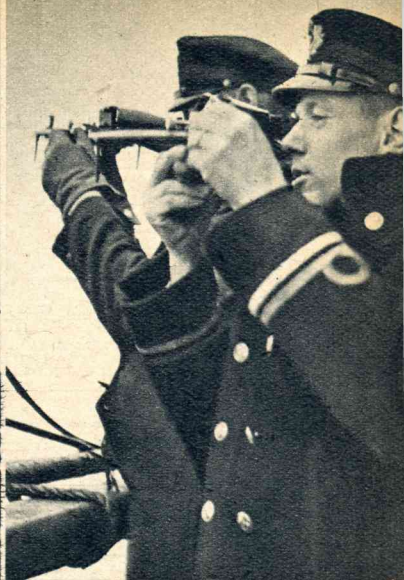
De commandant en de schipper „schieten zon” met de sextant.
