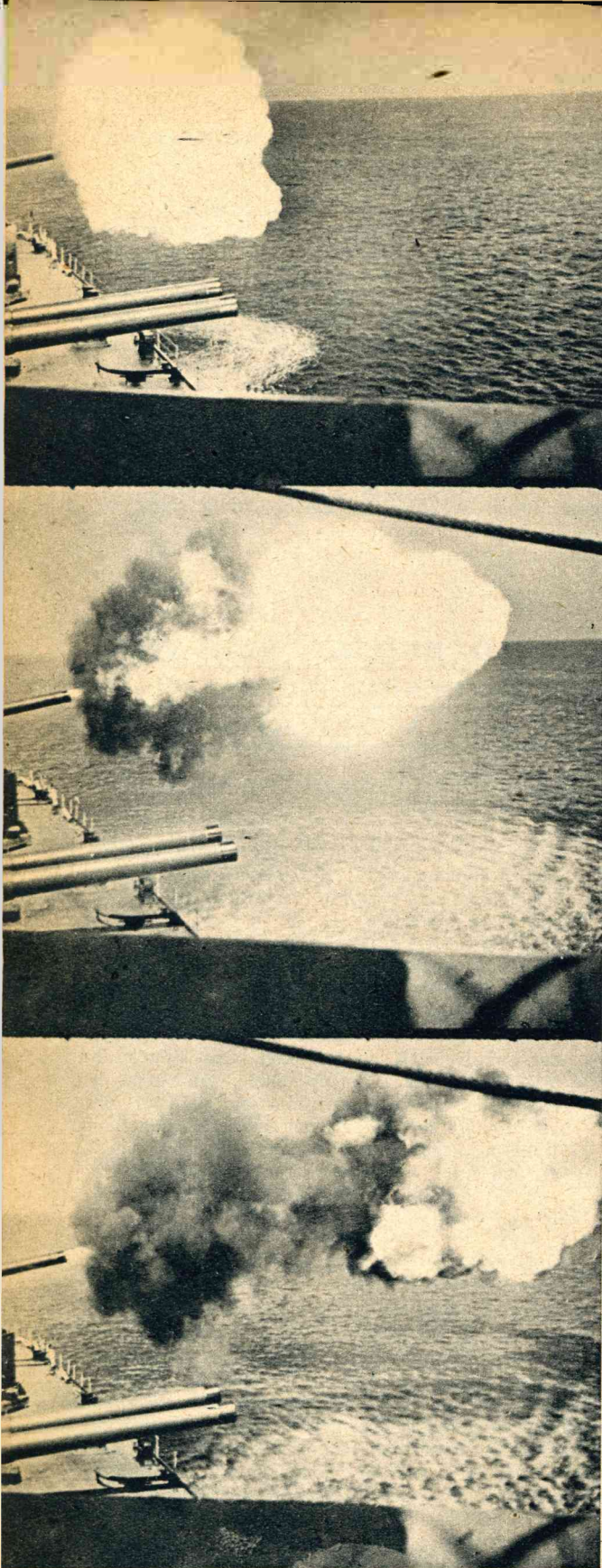
Het afschieten van een Engelsch scheepskanon eenige fracties van seconden achter elkaar genomen. Op de bovenste foto ziet men het projectiel, terwijl op de beide andere duidelijk de rimpels in het water te onderscheiden zijn, die veroorzaakt zijn door de trilling van het schip na het schot.
