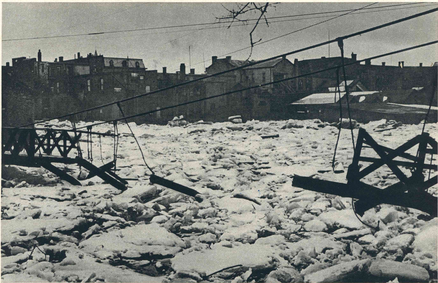
Een foto van een brug, die door de logge ijsmassa vernield werd. Drie weken lang bleef hier ter plaatse een geweldige ijssdam zitten.
