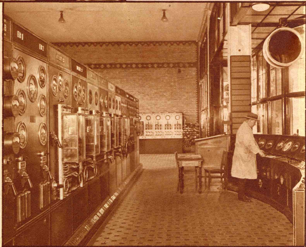
Naast de machinehal staan schakelborden en schakel-lessenaar opgesteld voor de bediening van de turbo-generatoren en meting van den opgewektenstroom. Van hieruit gaat de stroom naar de voedingskabels, via de schakelapparaten, die in verschillende verdiepingen van het schakelgebouw zijn ondergebracht.
