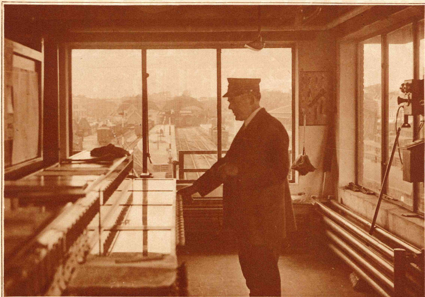
De maker over duizenden menschenlevens: een stemmingsvol kijkje in Post Eén bij het S.S.-station. Niet met de ouderwetsche handles, maar met eenvoudige knoppen worden hier wissels en signalen bediend.
