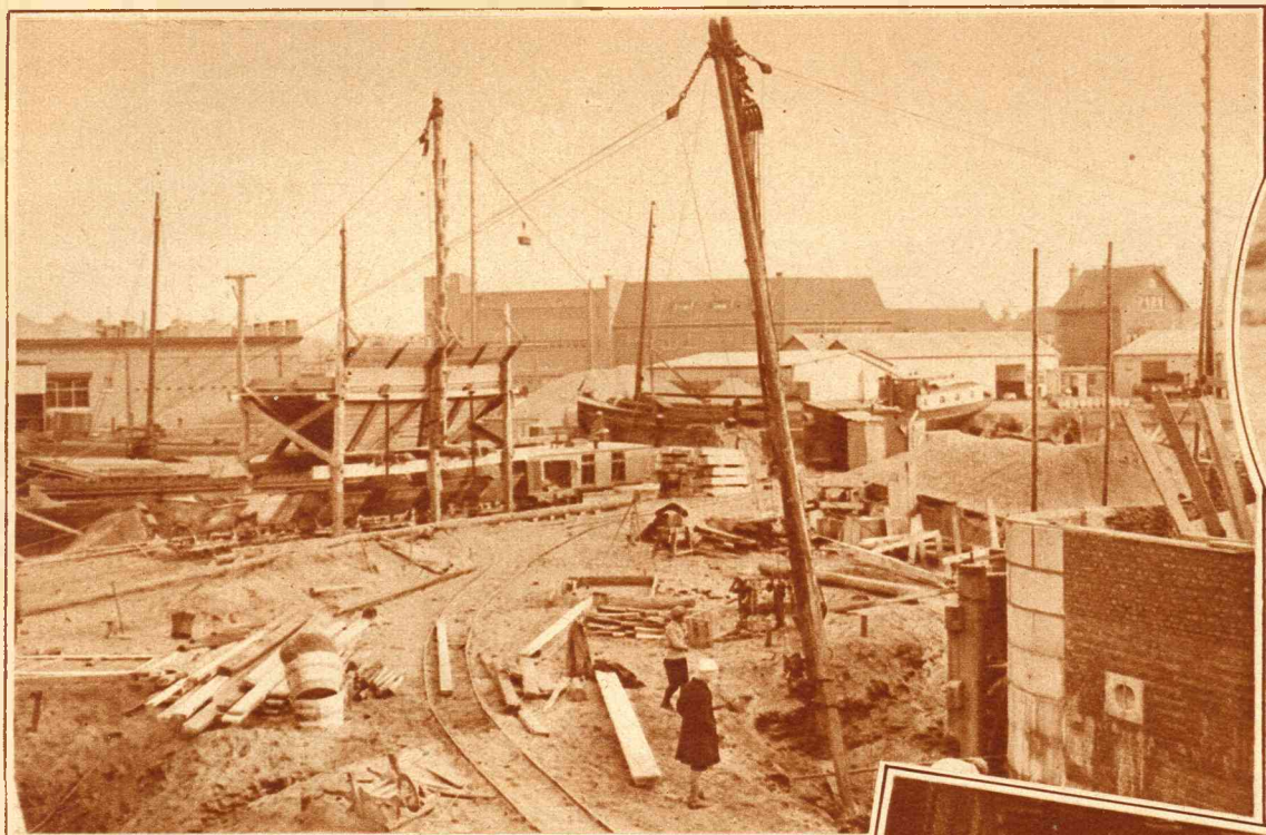
Een ruim overzicht op het werk aan de laatste verbinding tusschen het reeds gereedgekomen gedeelte en de Laak.
