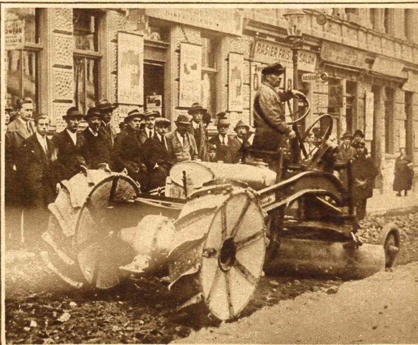
Een eigenaardig nieuw werktuig, uit Amerika in Weenen geïmporteerd en dat dient om bij straat-reparaties de deklaag van de straat open te rukken.
