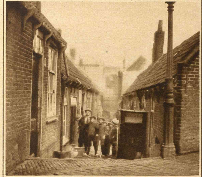
Nog meer onbewoonbaar verklaarde woningen op den Drogersdijk.
