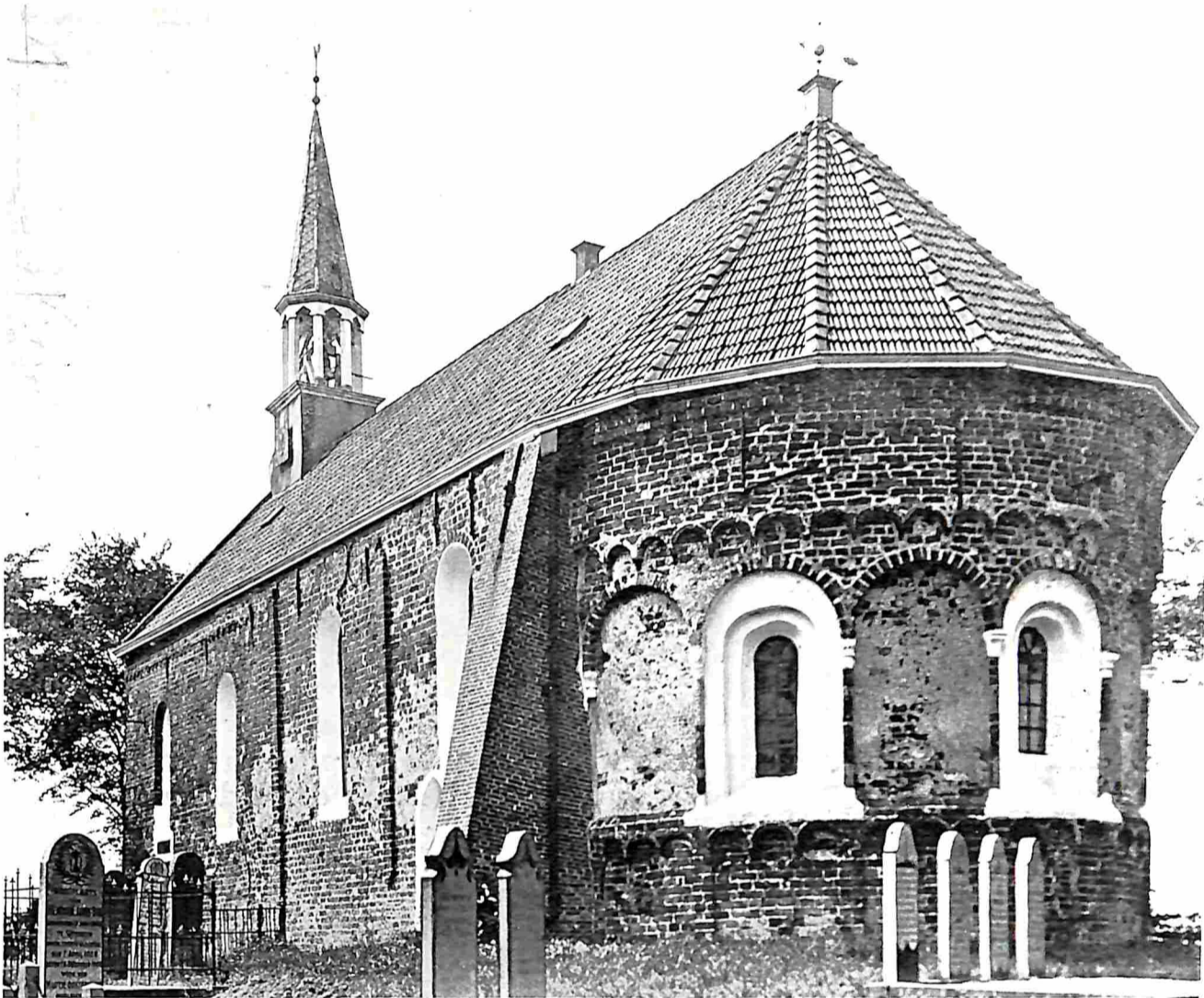
DE ROMAANSCH Kerk te Oldenziel. In de vorige eeuw van een nieuw dak, dakruiter en steunbeeren voorzien
