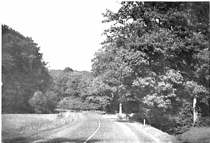
VERFSTREEP IN HET MIDDEN VAN DEN WEG ALS GELEIDING VOOR HET VERKEER. DE BOCHTEN ZIJN BOVEN-DIEN MET LAGE WITTE PAALTJES AANGEDUID. IN HET LANDSCHAP ZIJN DEZE WEINIG STOREND
