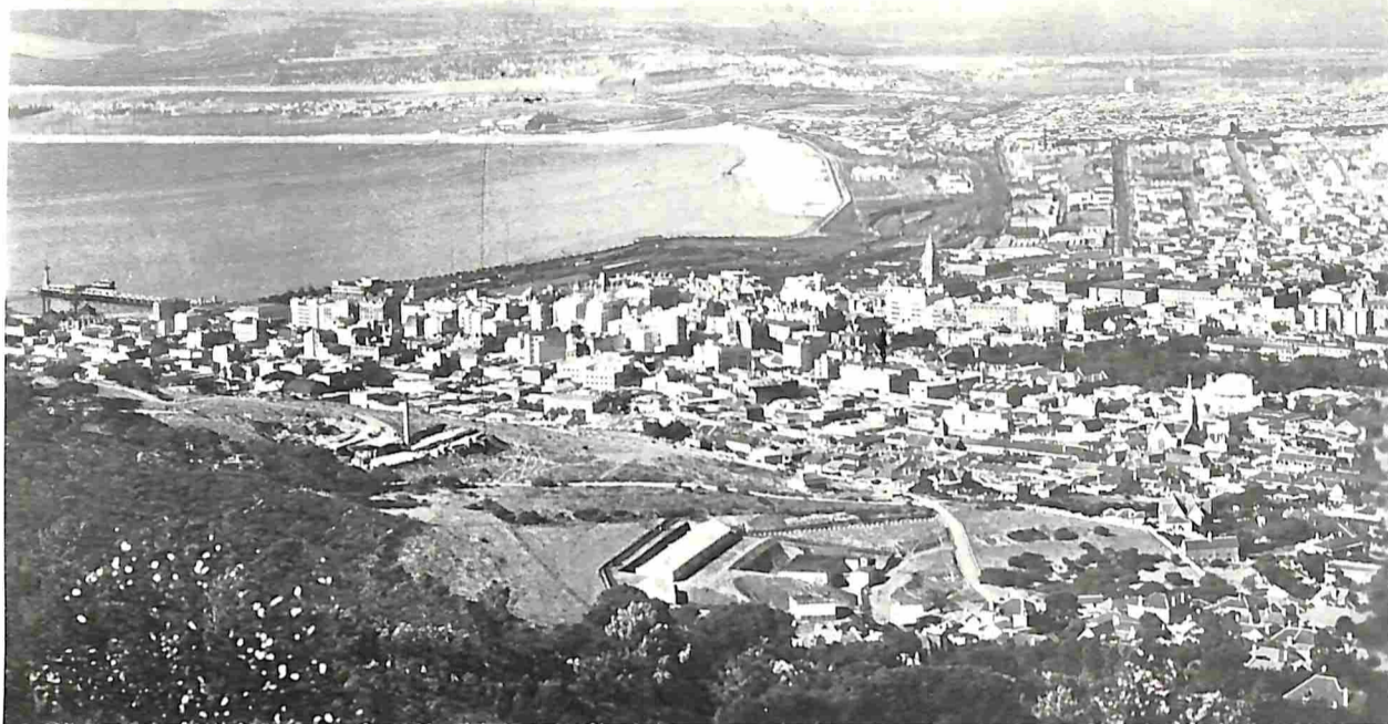
K.AAPSTAD GEZIEN VAN SIGNAL HILL
