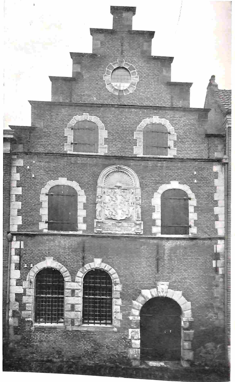
HET VOORMALIGE GRAANPAKHUIS IN DE KOESTRAAT TE SCHOONHOVEN
