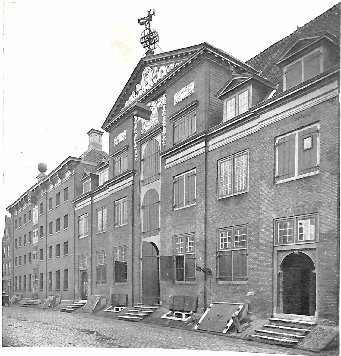
DE OOSTINDISCHE PAKHUIZEN ACHTER HET HOOFDGEBOUW IN DE BREESTRAAT TE MIDDELBURG
