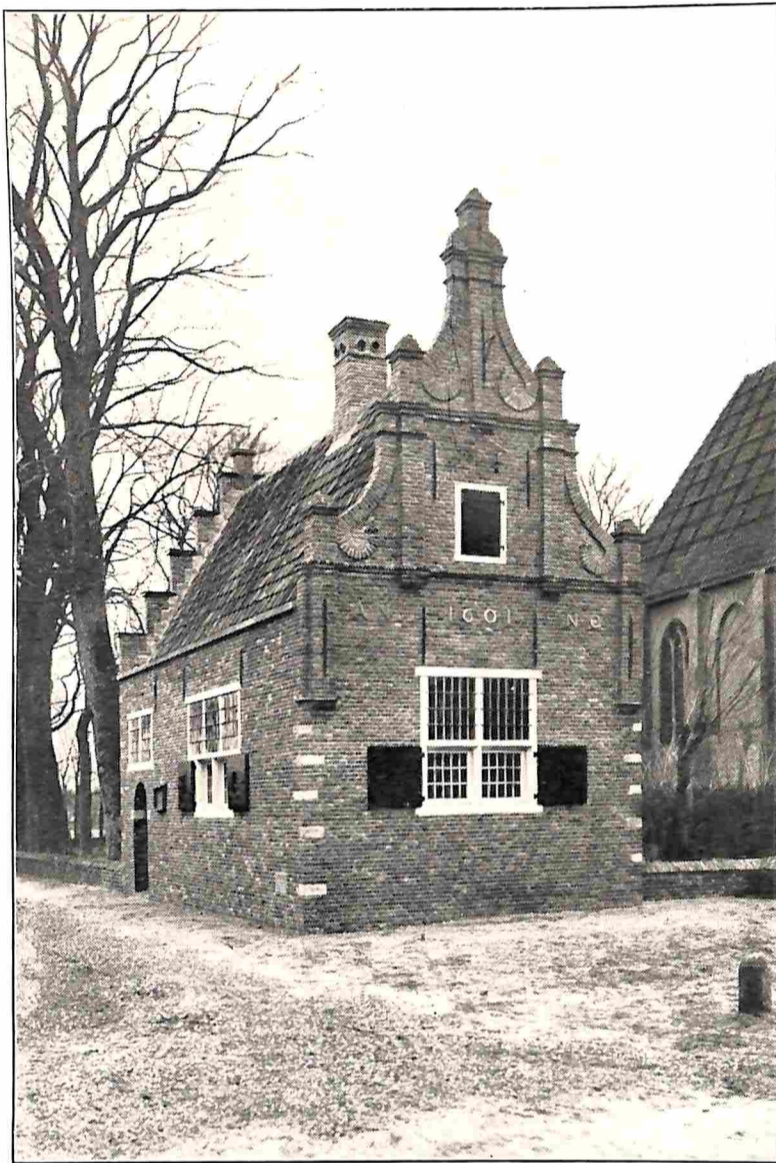
HET VOORMALIGE RAADHUISJE TE SCHOORL. DAT DOOR DE VEREENIGING „HENDRICK DE KEYSER“ IN EIGENDOM WERD VERKREGEN EN DOOR HAAR IN OUDEN LUISTER WERD HERSTELD ARCH. J. DE WYK
