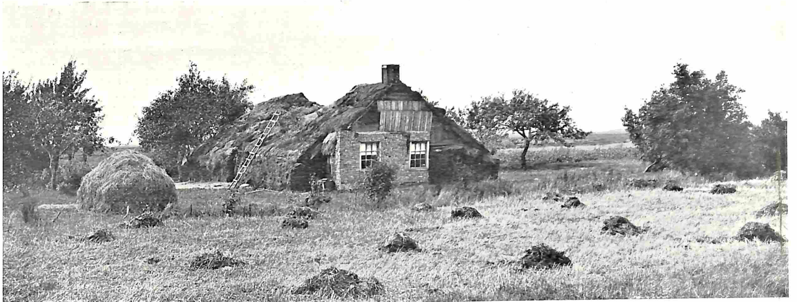
WONING OP DE DRENTSCHE HEIDE, VOOR HET GROOTSTE DEEL VAN HEIDEPLAGGEN GEBOUWD
