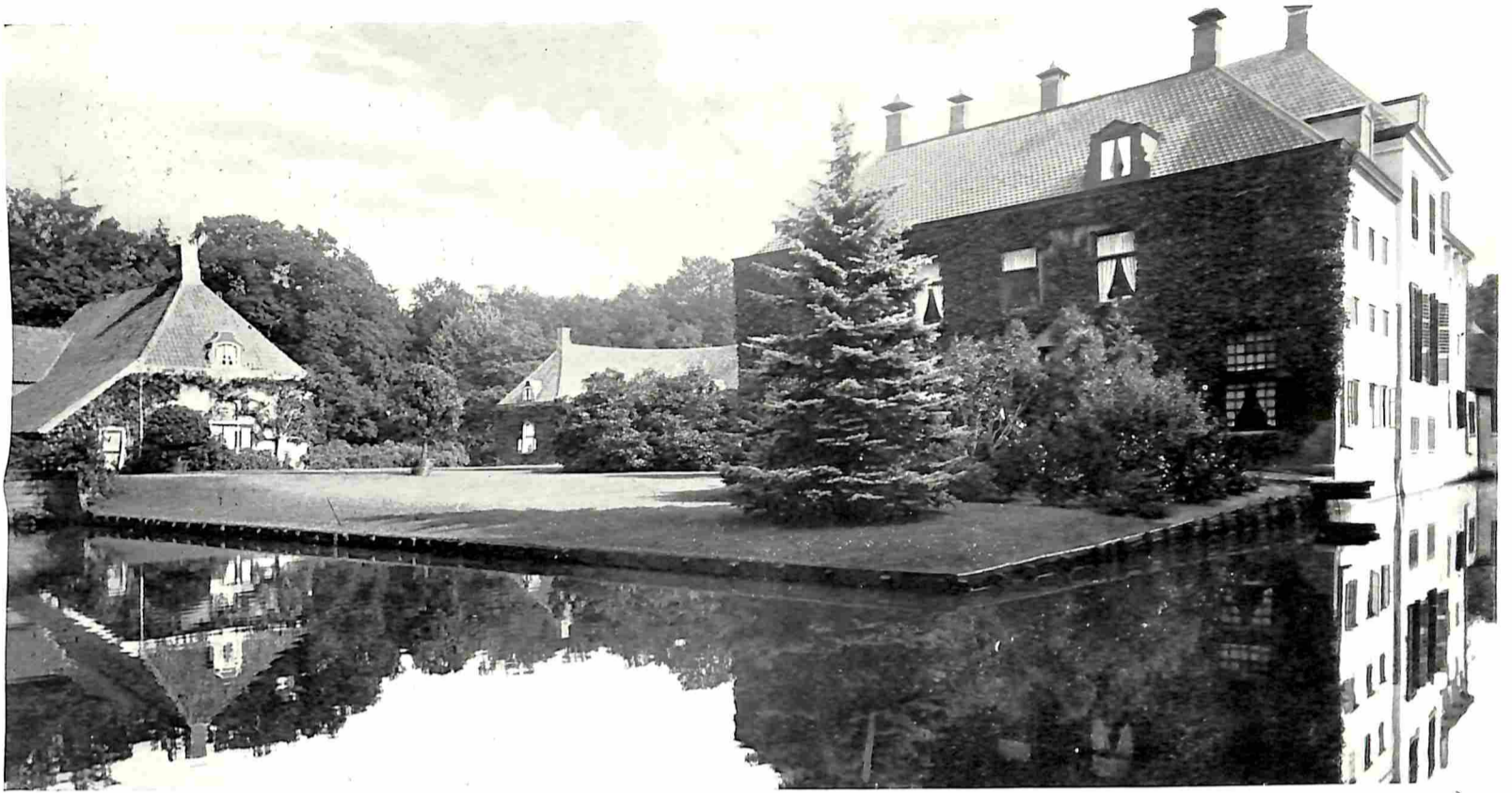
HET HUIS SCHOONHEETEN, WESTZIJDE MET GEZICHT OP ACHTERGEVEL
