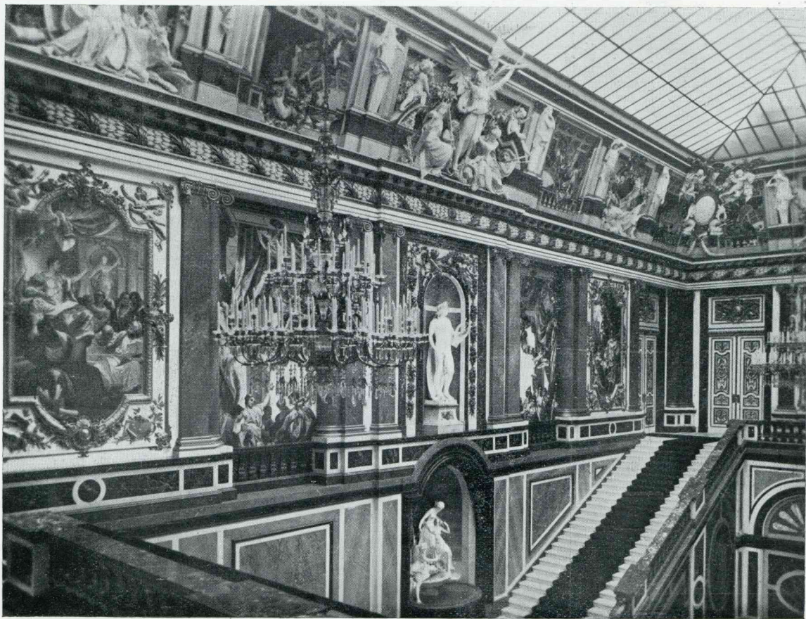
SLOT HERRENCHIEMSEE. TRAPPENHUIS
