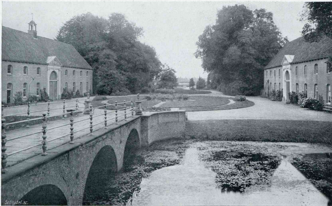
DE CANNENBORG. VOORPLEIN MET DE BOUWHUIZEN
