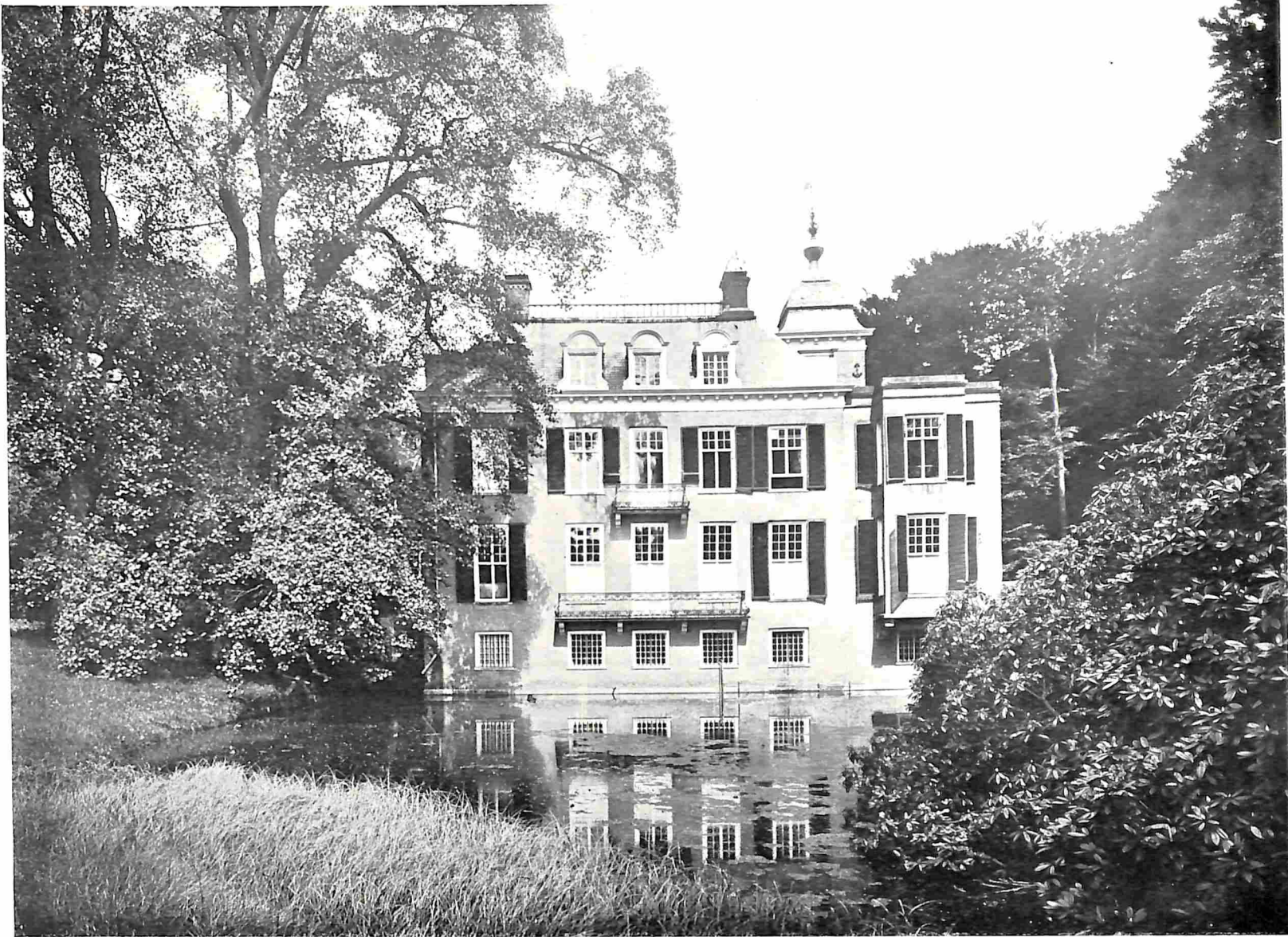
HUIZE ZIJPENDAL. ACHTERGEVEL
