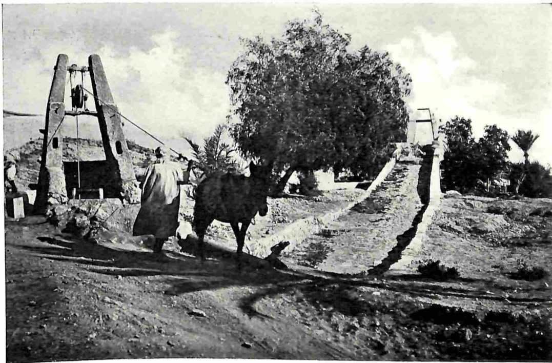
WATERPUT TE GHARDAÏA.
