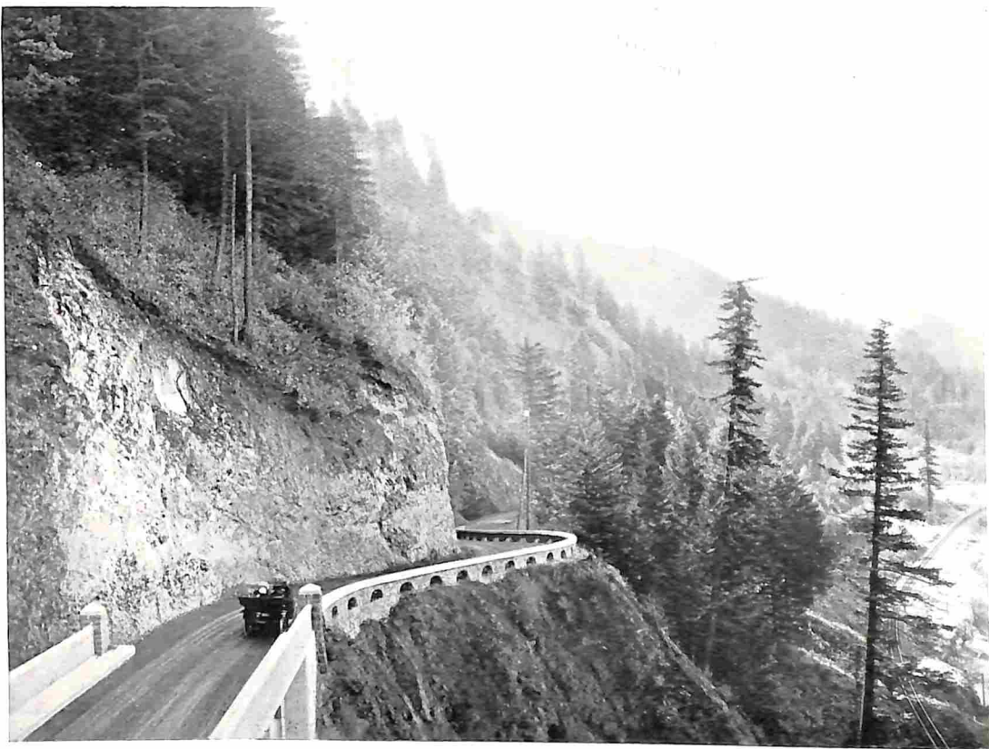
DE COLUMBIA RIVER HIGHWAY IN DEN STAAT OREGON.
