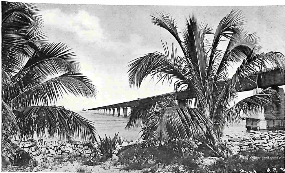
AAN DE KUST VAN FLORIDA MET DE SPOORBRUG OVER ZEE NAAR KEY WEST.
