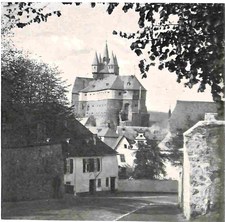
HET KASTEEL DIEZ, GEZIEN VAN HET ZUIDEN. BENEDEN RENAISSANCE GEBOUWEN VOOR DE ADMINISTRATIE.
