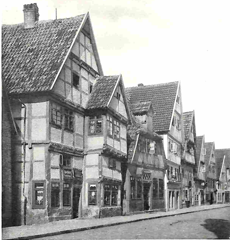
OUDE HUIZEN AAN DE KRUMME STRASSE TE DETMOLD.
