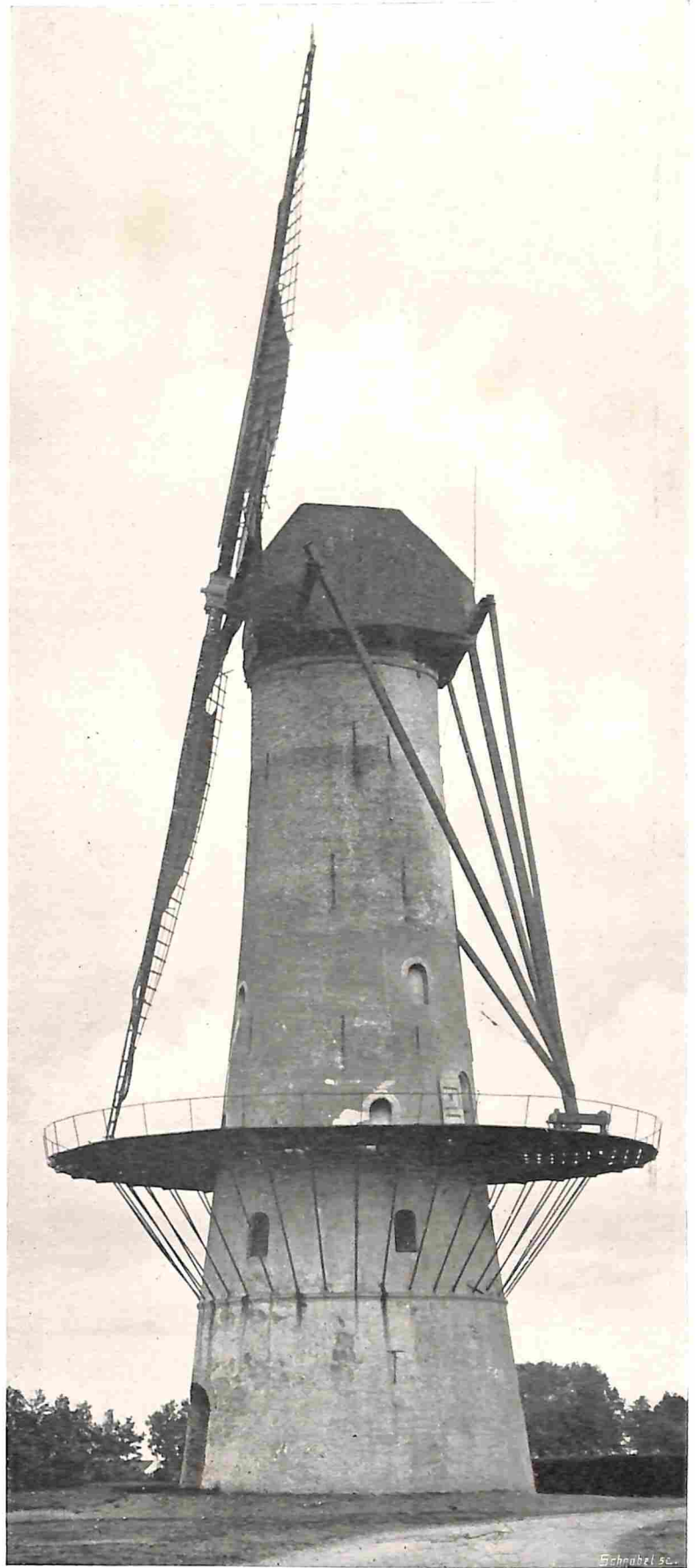
ONZE WINDMOLEN-TYPEN. HOOGHE RONDE STEENEN BOVENKRUIER. KORENMOLEN BIJ STEENDEREN.
