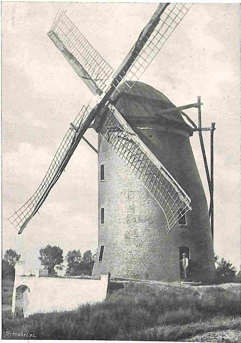
ONZE WINDMOLEN-TYPEN. LAGE RONDE STEENEN BOVENKRUIER. KORENMOLEN BIJ HEERLEN.
