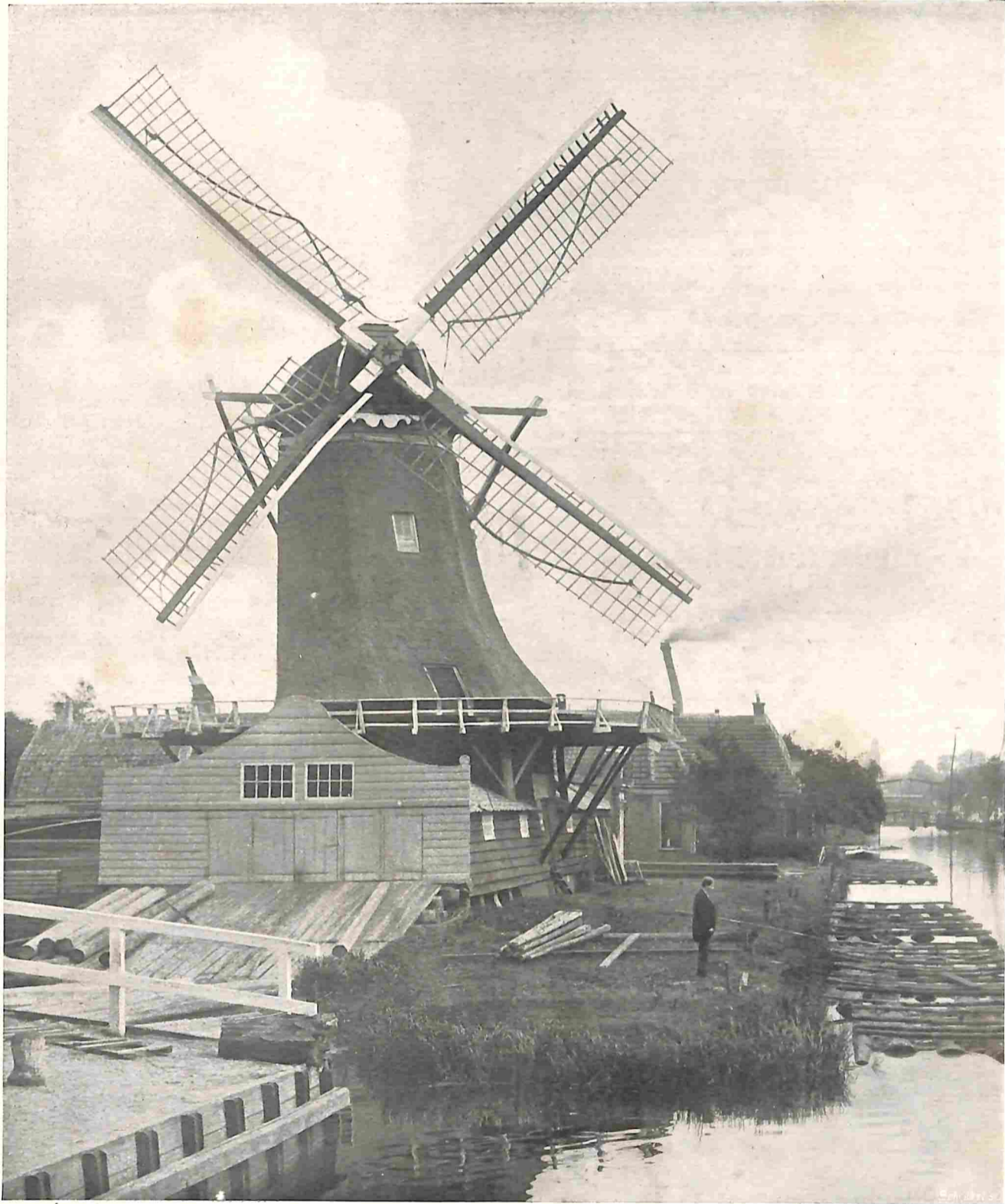
ONZE WINDMOLEN-TYPEN. HOUTZAAGMOLEN-BOVENKRUIER BIJ UTRECHT.
