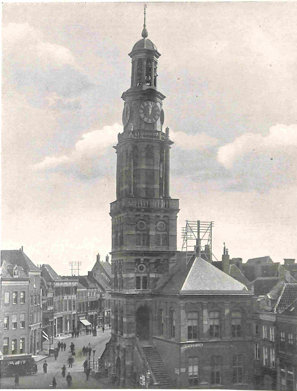
DE WIJNHUISTOREN TE ZUTPHEN, WAARVAN HET HOUTEN BOVENGEDEELTE MET DEN KOEPEL DE VORIGE WEEK DOOR BRAND VERWOEST IS.
