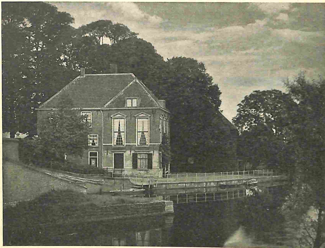
HET GEMEENLANDSHUIS VAN DEN OVERWAARD TE ELSHOUT VÓÓR DE VERBOUWING.
