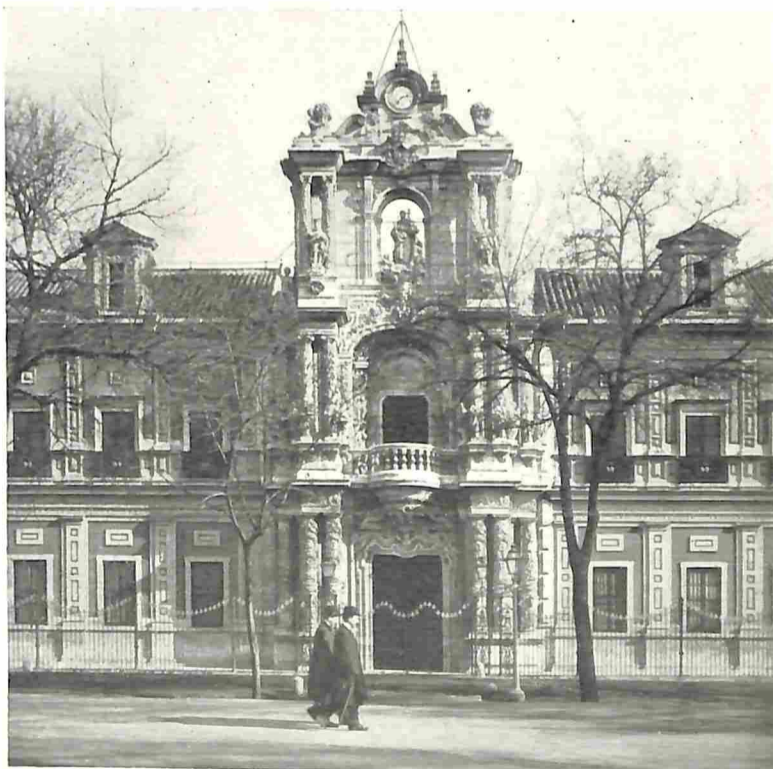
VOORGEVEL VAN HET PALEIS „SAN TELMO" TE SEVILLA.
